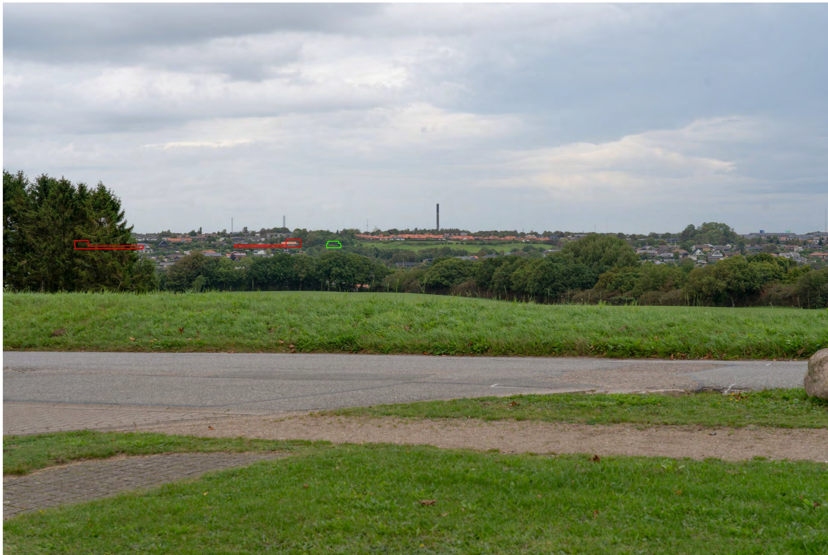
Standpunkt 9 – Overbyvej ved Grønnevangen – Markering af placering A og B (røde konturer) samt byggefelterne 1 og 2 i lokalplan 0734-33 (grøn kontur). Konturstregerne angiver, at ny bebyggelse ikke er synlig
