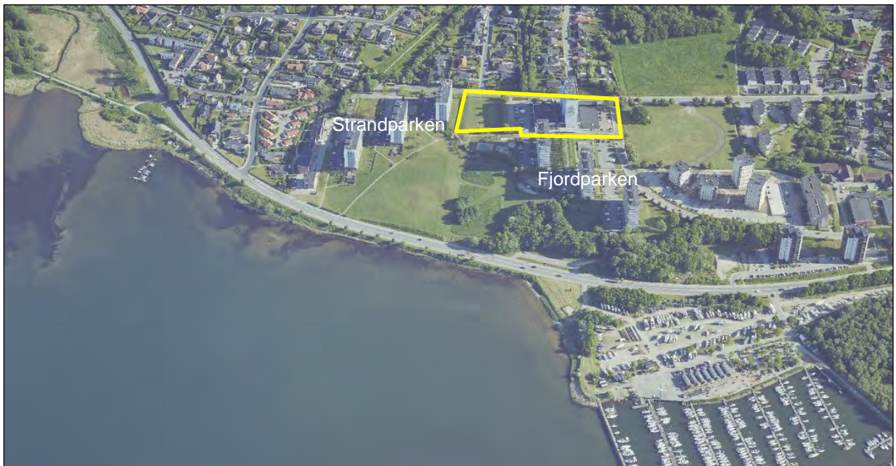
Figur 7. Skråfoto med planområdet (angivet med gul kontur) i forhold til de markante omkringliggende bebyggelser Strandparken og Fjordparken.
