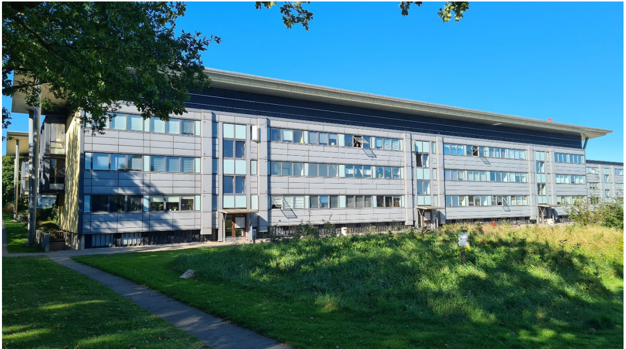
Foto af den eksisterende etageboligbebyggelse i planområdet, der planlægges nedrevet.
