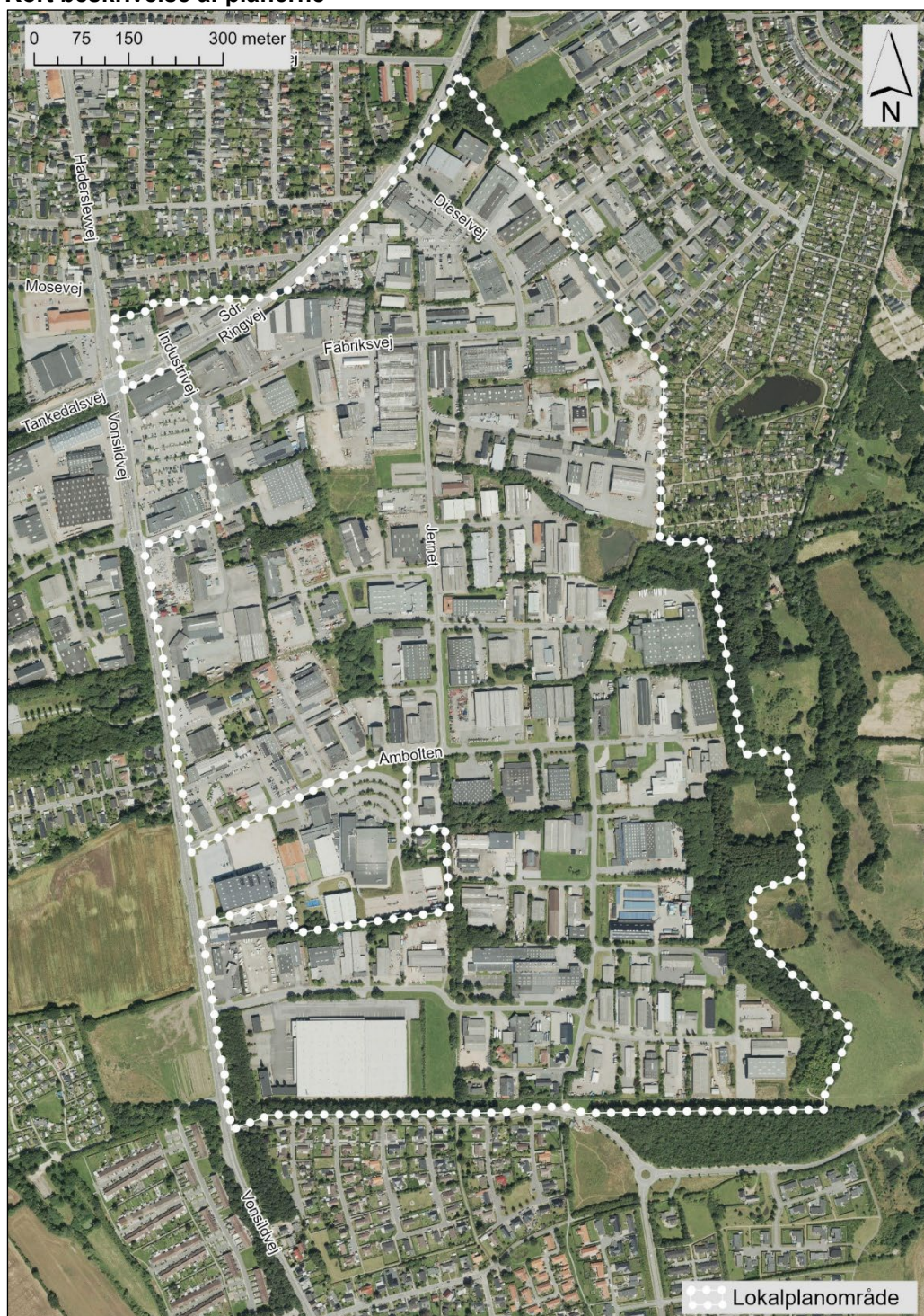
Luftfoto med lokalplanområdets afgrænsning.
