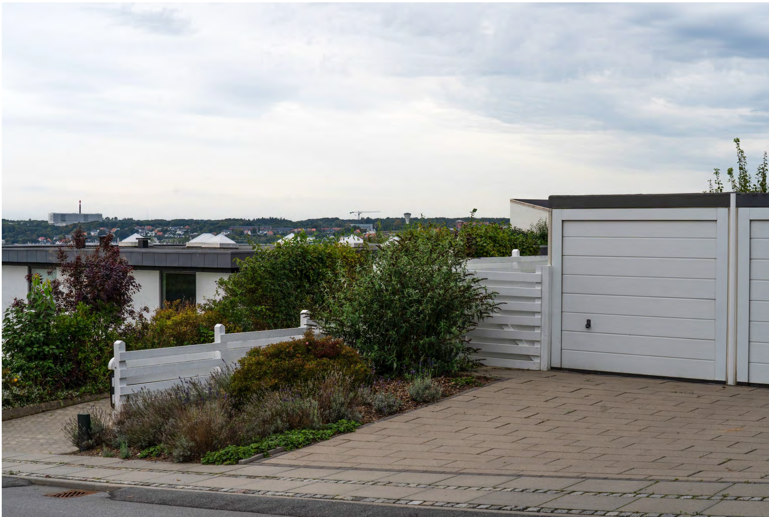
Standpunkt 8 – Søbakken 16/18, Rebæk - Nuværende forhold
